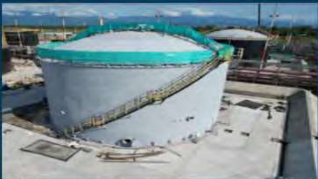
Aislamiento térmico con recubrimiento líquido
